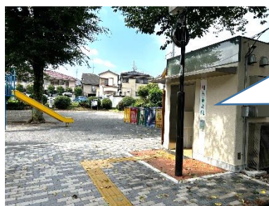
① 入口から見たトイレ
