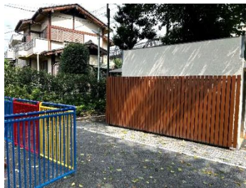
③ 公園奥から見たトイレ
