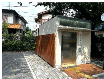
② 公園内から見たトイレ
