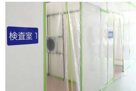
【写真2】ビニールカーテンで仕切られたHEPAフィルタ付簡易陰圧室構造の検査室
