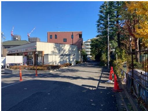
⑦板橋公園北側の状況
