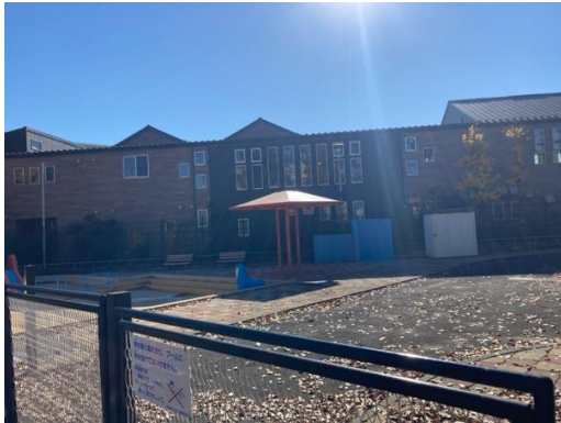
⑤板橋公園南側の状況
