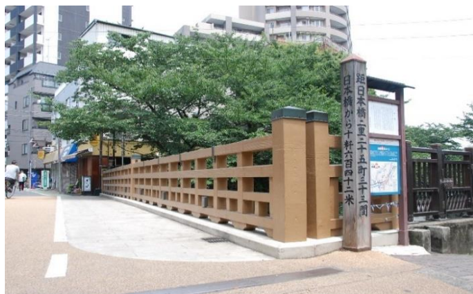
インフラ資産（板橋）
